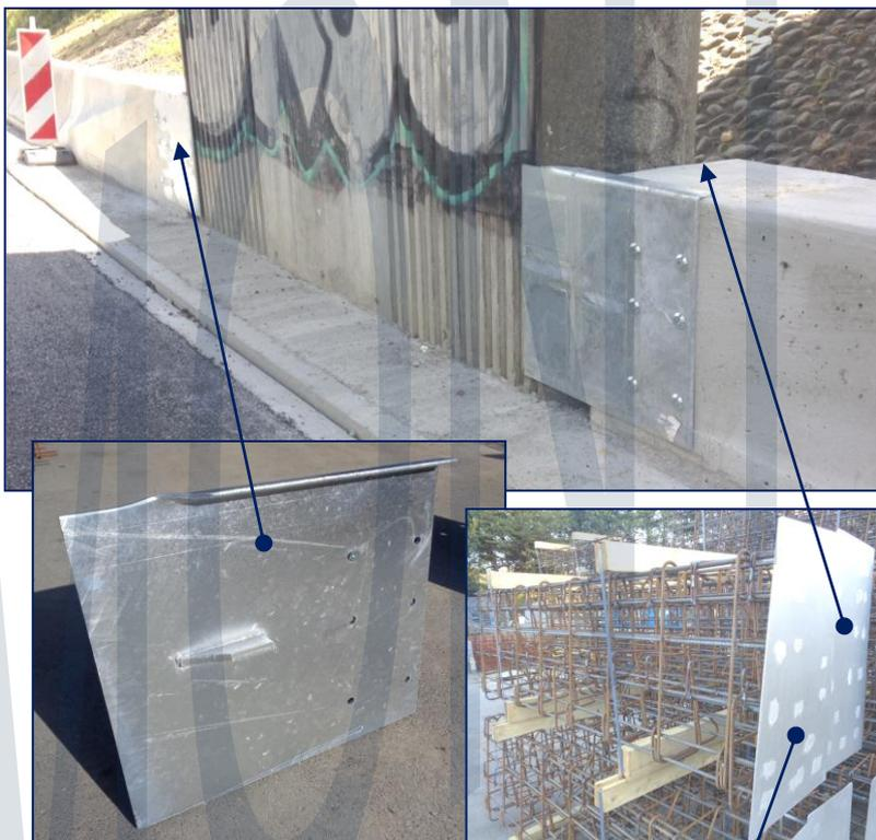
**2<sup>ème</sup> configuration** : le talon du séparateur se situe en avant de la pile de pont.
