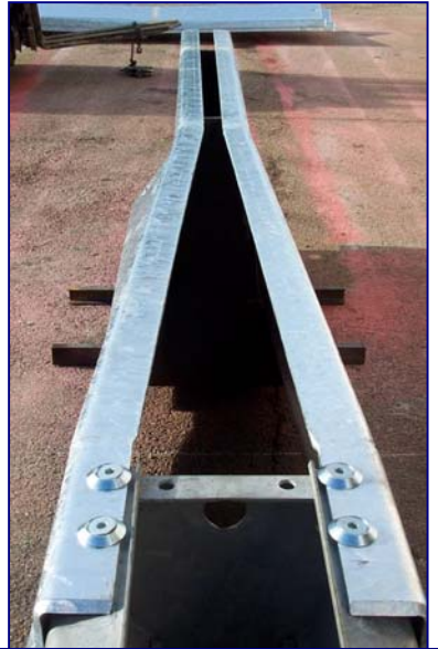
Raccordement profil préfa 07 béton sur profil SAFEGUARD
