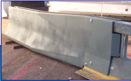
Raccordement profil préfa 07 béton sur profil VARIOGUARD
