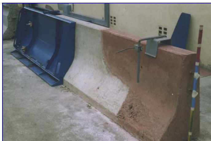
❸ Ragréage d'un séparateur GBA H800 avec talon de 80mm
