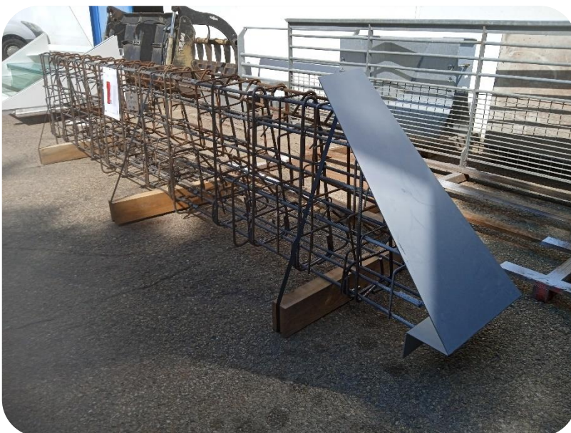
Armature hélice lg 4000 de raccordement sur paroi tunnel GBA - sortie GIRAUDE sens Italie-France-TPC
